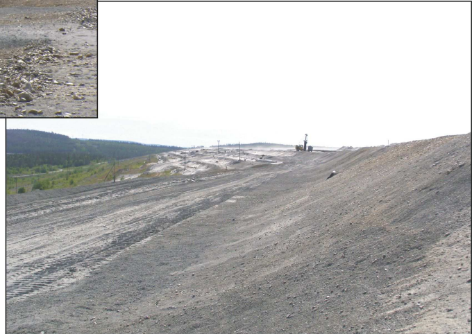
Рис. 1. Создание полимерного покрытия прекращает ветровую эрозию (хвостохранилище ОАО "Ковдорский ГОК"; передний план, до осветительной мачты)
