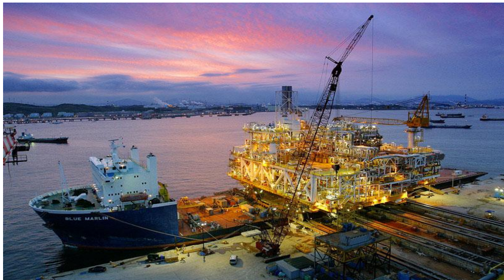
Рис. 1. Выгрузка (выкатка) КТГ по рельсам на берег; http://www.dockwise.com/page/projects/projectdata-27.html
