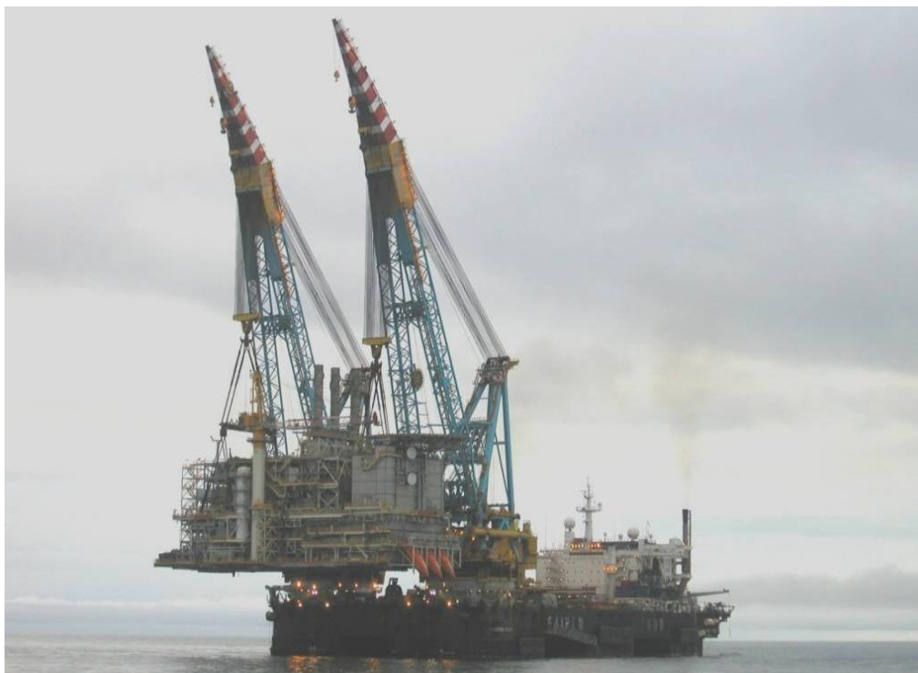
Рис. 5. Плавающий грузоподъемный кран Saipet-7000 в работе; http://korabley.net/news/krupnejshij_v_mire_plavuchij_gruzopodemnyj_kran_saipet_7000/2011-11-03-994
