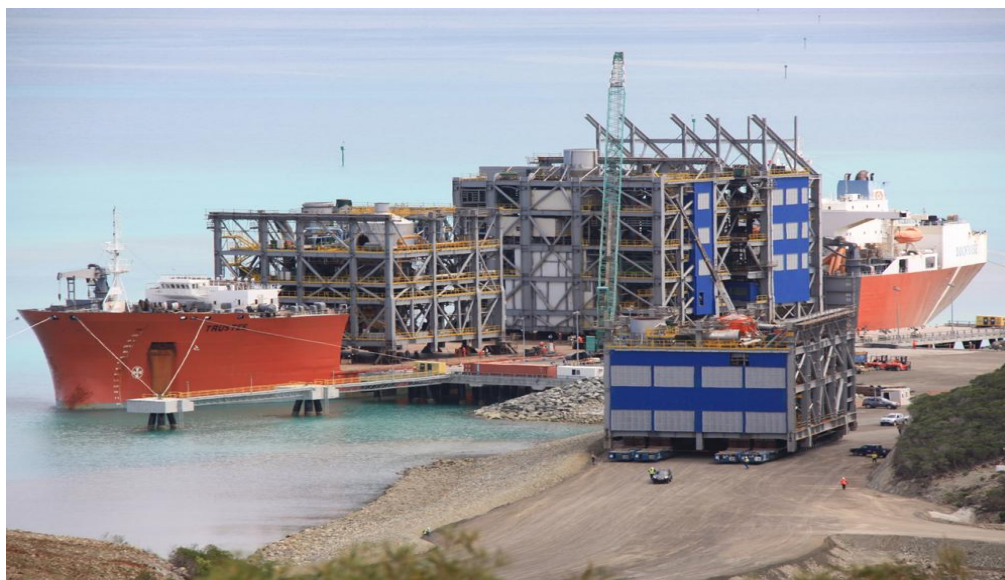
Рис. 2. Горизонтальная выгрузка (выкатка) КТГ, осуществляемая с помощью СМТ; http://www.sarens.ru/media/251016/koniambo_4.jpg
