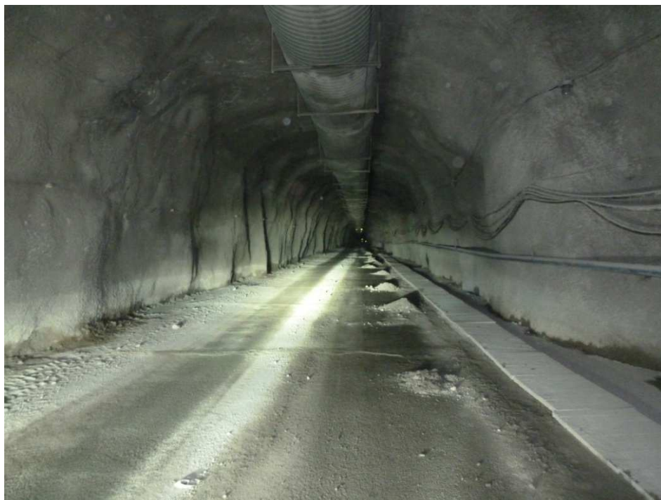
Рис. 4. Общий вид транспортной штольни
