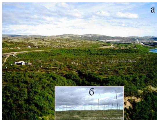
Рис. 1. Рабочее здание радиофизического полигона "Туманный" и антенное поле (а), элементы антенной решетки (б)
