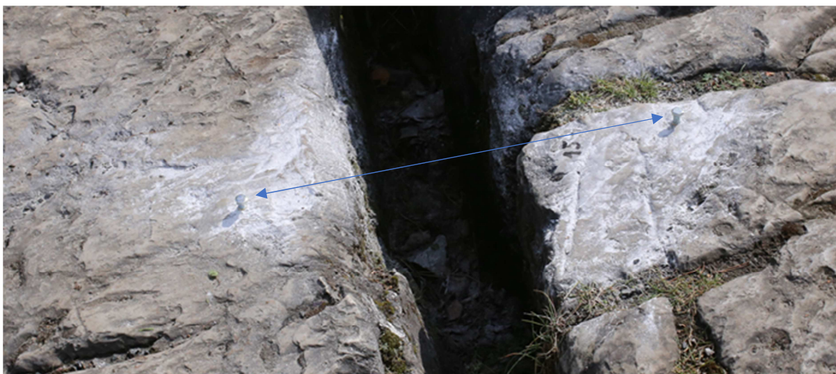
Fig. 15. Scheme to install metal screws embedded in the rock for measurements with laser devices Рис. 15. Схема установки металлических саморезов (реперов) в скале для измерений лазерными устройствами
