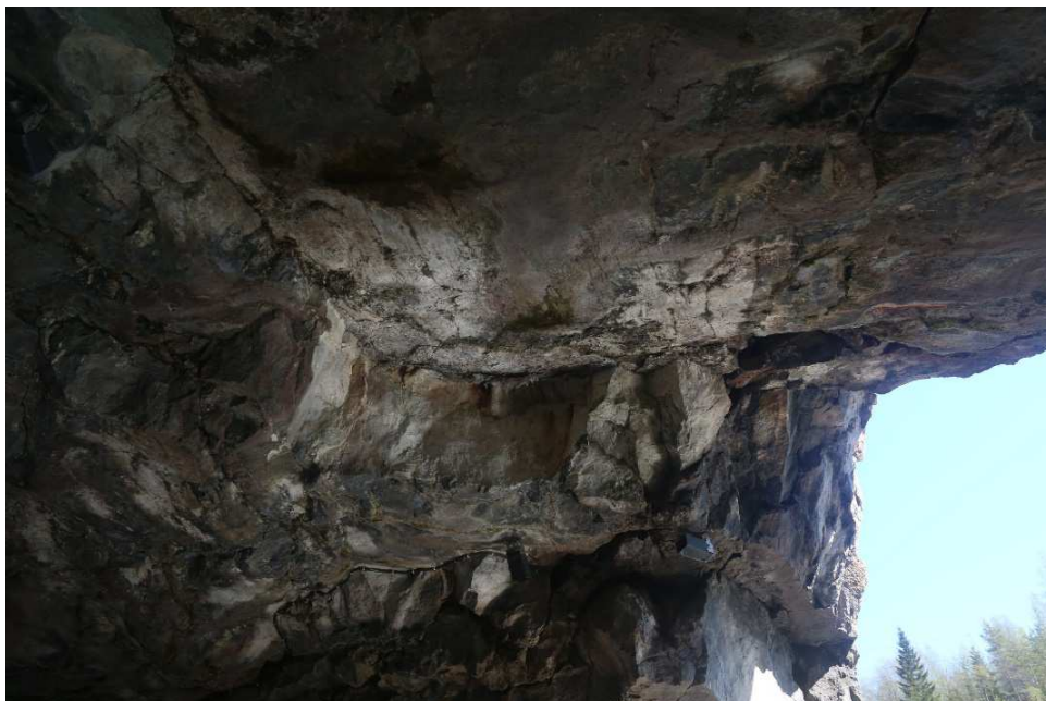
Fig. 12. The character of the cracking on the site adjacent to the exit of the gallery (photo by V. Shekov) Рис. 12. Характер трещиноватости на участке, примыкающем к выходу из галереи (фото В. Шекова)
