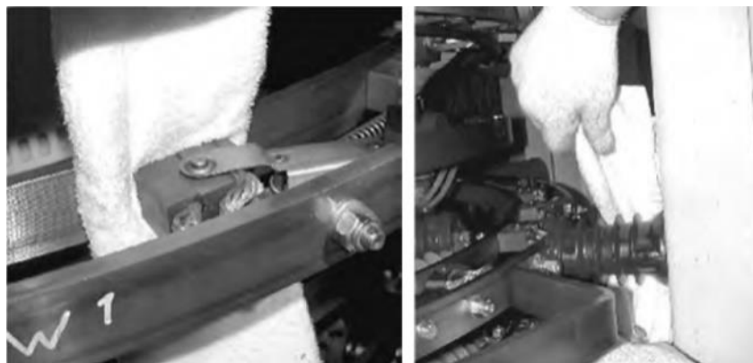
Рис. 3. Чистка щеток и изоляторов Fig. 3. Cleaning brushes and insulators
