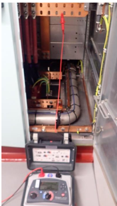
Рис. 6. Измерение сопротивления изоляции обмотки статора ГЭД высоковольтным мегаомметром Fig. 6. Measuring the insulation resistance of the stator winding of the hydroelectric motor with the high-voltage megohmmeter
