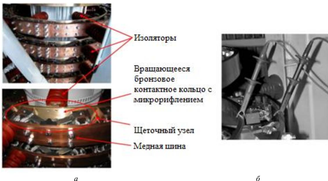
Рис. 2. Элементы узла контактных колец (а) и методика измерения сопротивления между контактными кольцами и наружной шиной (б)
